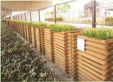
国道43号線 出来島~大和田西付近(約150m)
